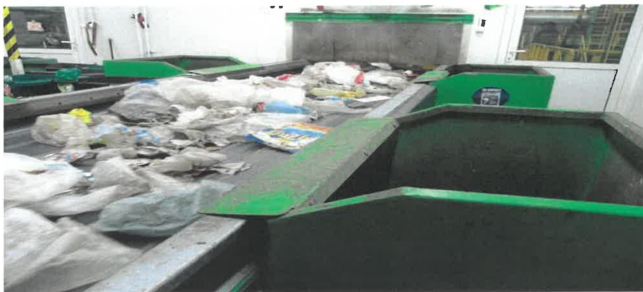
Fot. 7.4. Regionalny Zakład Gospodarki Odpadami w Woli Pawłowskiej – sortownia.
