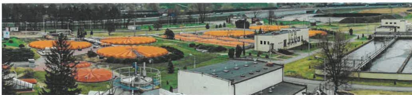
Fot. 3.2 Zakład „Pruszków” po modernizacji zakończonej w 2015 roku (źródło: Krzysztof Kobus Travelphoto.pl dla MPWiK w m.st. Warszawie S.A.)
