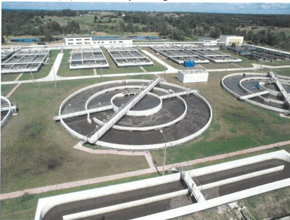
Fot. 3.3. Miejska oczyszczalnia ścieków w Radomiu (źródło: Wodociągi Miejskie w Radomiu Sp. z o.o.)
